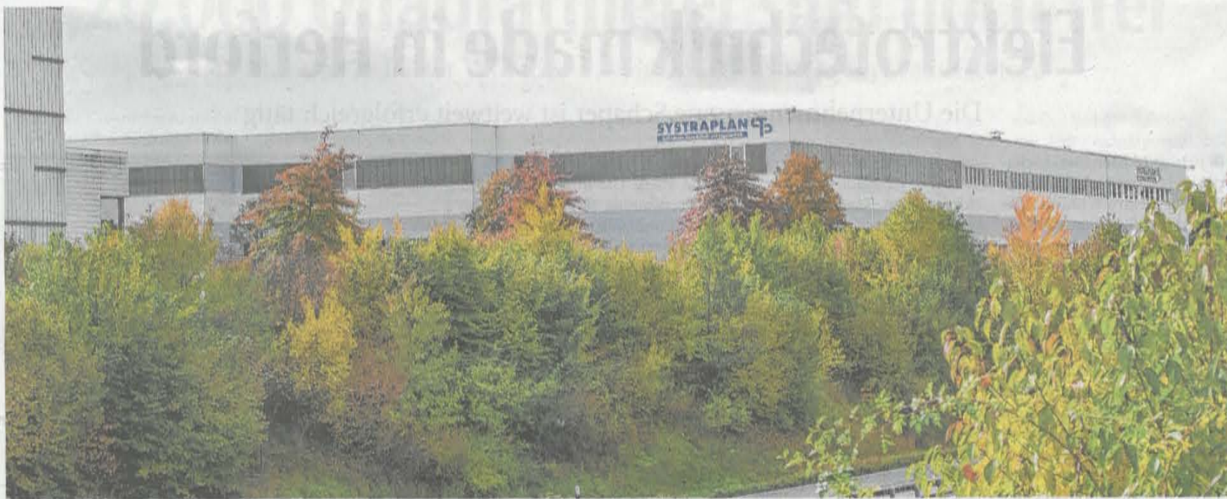
Umrahmt von Bäumen: Das Firmengebäude von Systraplan von der anderen Seite der B239 aus gesehen.
